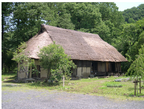
市指定有形文化財(建造物) 「内田家住宅」
